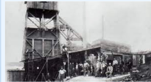
Escondido's Oro Fino Mine in the 1890s
